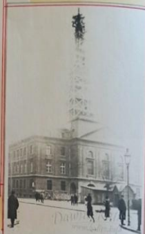
Budowa ratusza kaliskiego. fotografia z archiwum Miasta Kalisz, ok. 1924 r.
